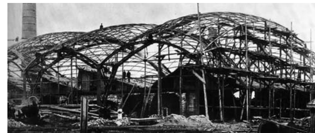
ВЛАДИМИР ШУХОВ Строительство первых в мире сетчатых конструкций — оболочек-перекрытий двоякой кривизны Металлургический завод г. Выкса / 1897
